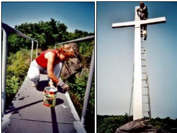
Renovace vrcholového zařízení – přístupová lávka a zábradlí nad skalami, vrcholový kříž a ochoz.
